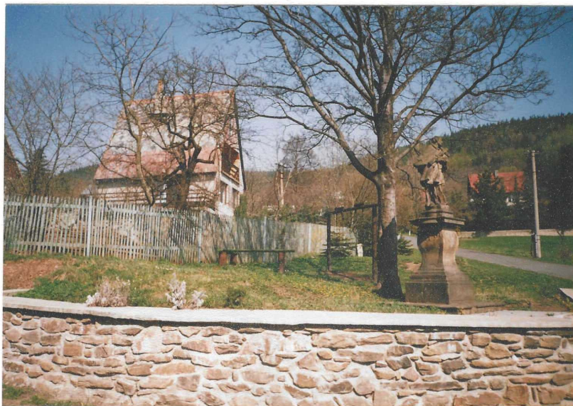
Opravená zed v Blahunově
