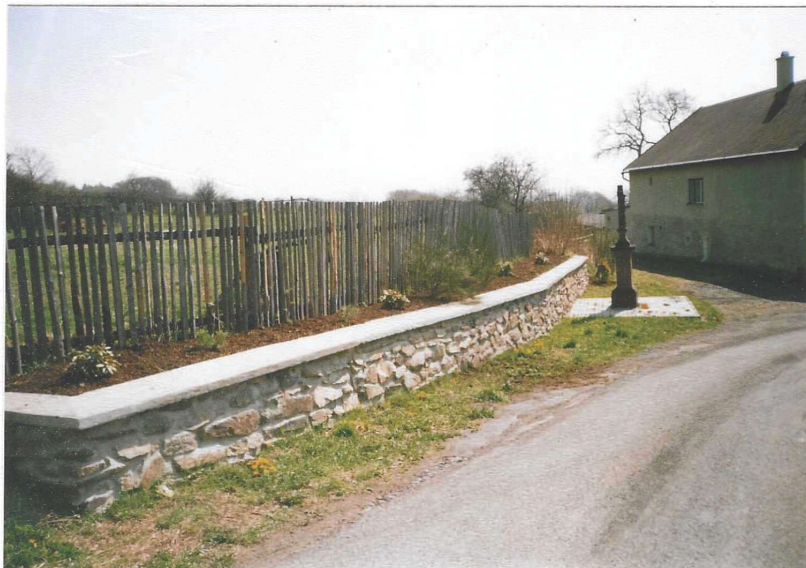
Opravené zdi v Blahunově Prohram obnovy venkova
