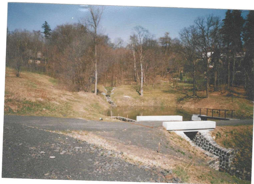
Opravené Hasíkovy nádrže
