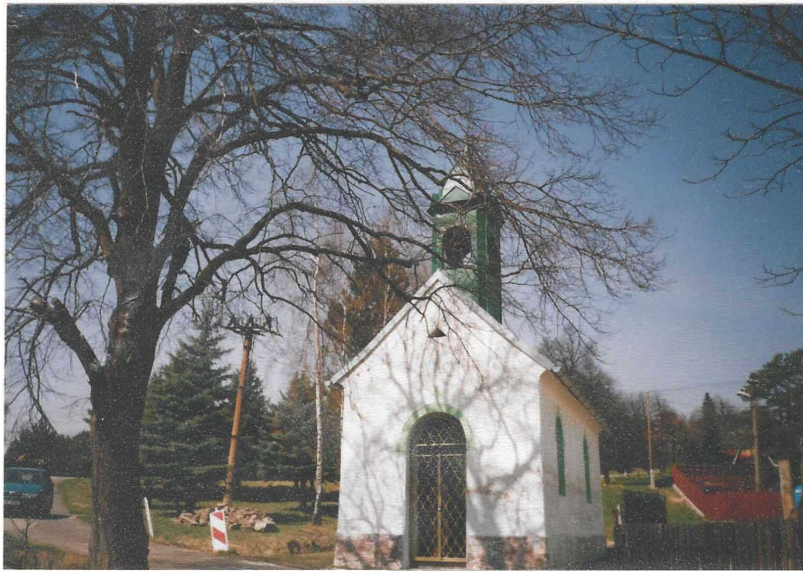
Opravená kaplička ve Vysoké Jedli- program Obnovy venkova
